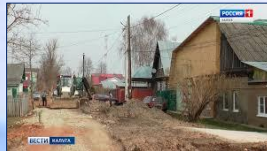
Строительство сетей канализации ул.Колхозная – 603,718 тыс. руб
