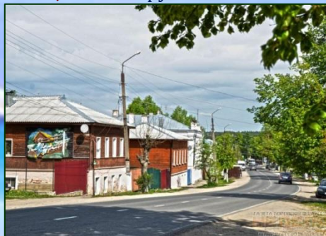
Строительство канализации ул.Калужская (1 очередь) – 2 160,981 тыс. руб.
