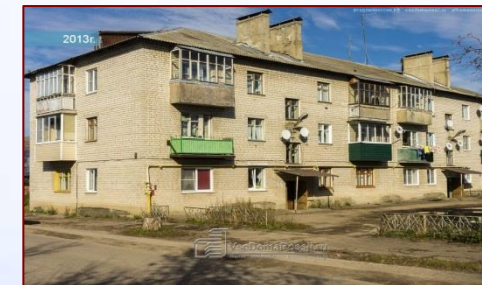
Ремонт кровли дома №7 ул.Володарского за счет Фонда капитального ремонта
